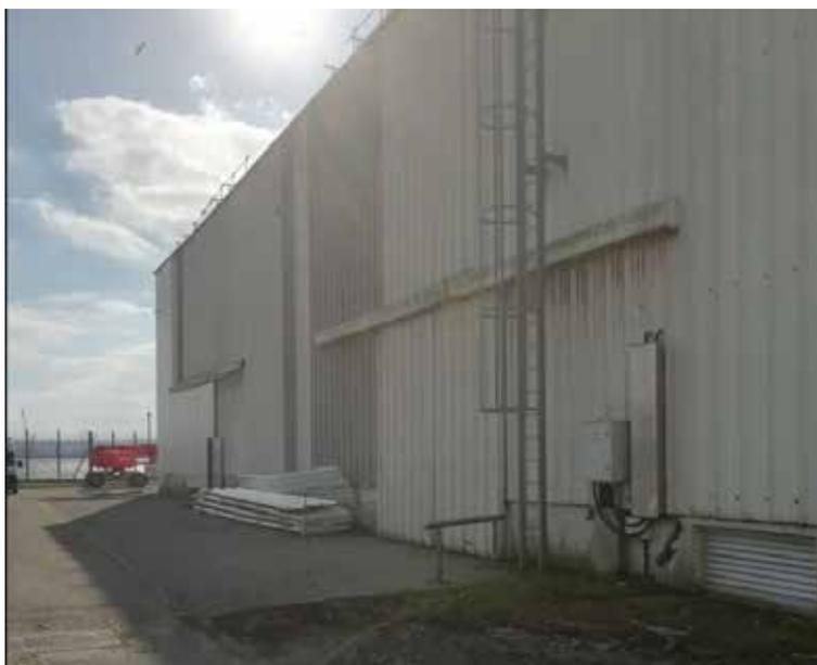
Réalisation d'un bardage simple peau (2100 m<sup>2</sup>) et d'une couverture bac acier (2450m<sup>2</sup>) par l'Agence **ROSAY** de CHERBOURG.
